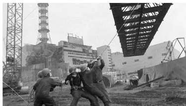
Монтаж опорной стены саркофага ЧАЭС, 1986 г.
